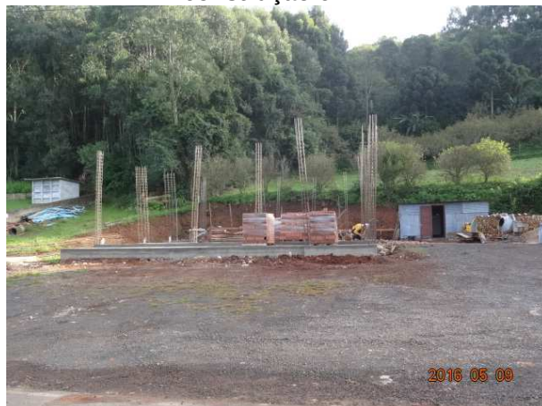
Figura 121: Pequeno gerador de resíduos da construção civil.
