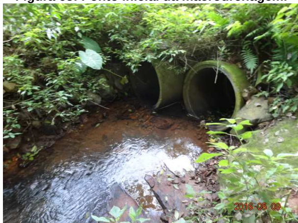
Figura 65: Ponto inicial da macrodrenagem.
