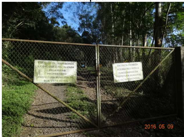
Figura 82: Entrada da estação de transbordo, licenciada pela FEPAM.
