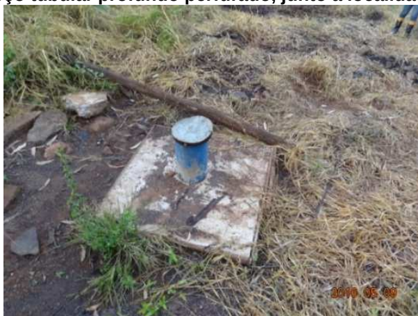
Figura 48: Novo poço tubular profundo perfurado, junto a localidade de Santa Helena.
