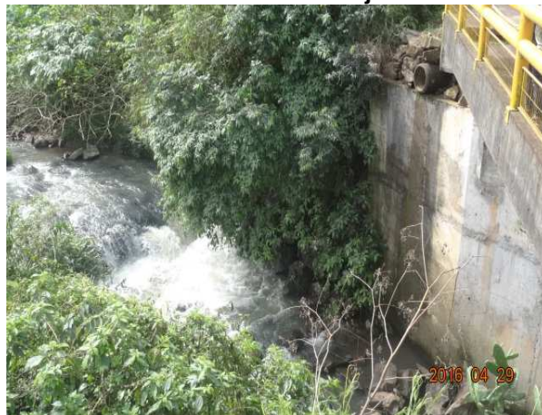
Figura 71: Vista da canalização pluvial que desemboca no arroio Boa Vista junto a rua Itália.
