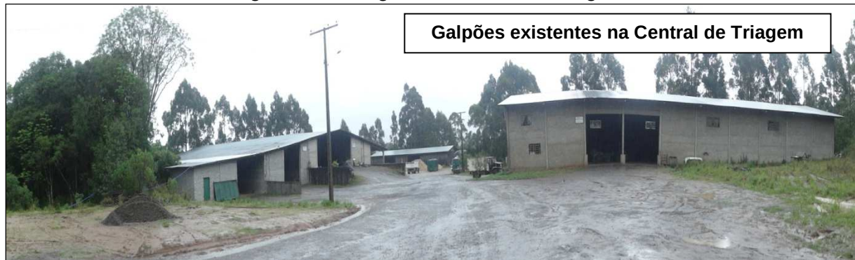
Figura 91: Vista geral da Central de Triagem.
