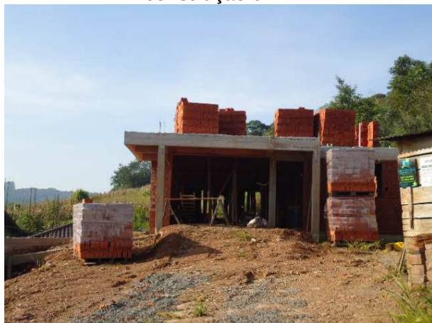
Figura 120: Pequeno gerador de resíduos da construção civil.
