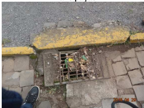
Figura 61: Boca de lobo localizada na rua Emancipação.
