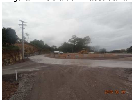
Figura 14: Obra de infraestrutura.
