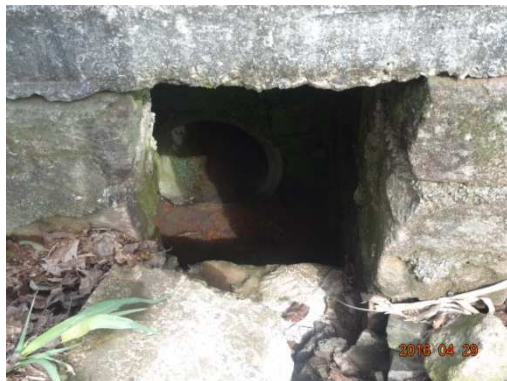
Figura 63: Rede de drenagem encontrada na rua Bela Vista.
