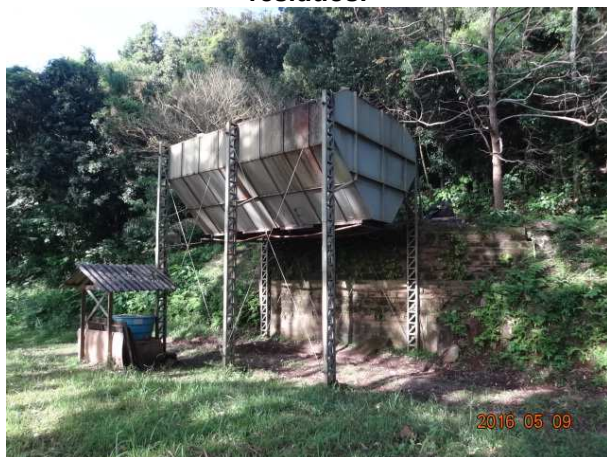
Figura 84: Armazenamento provisório dos resíduos.
