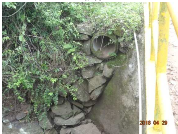
Figura 70: Vista da canalização pluvial que desemboca no arroio Boa Vista junto a rua Rio Branco.
