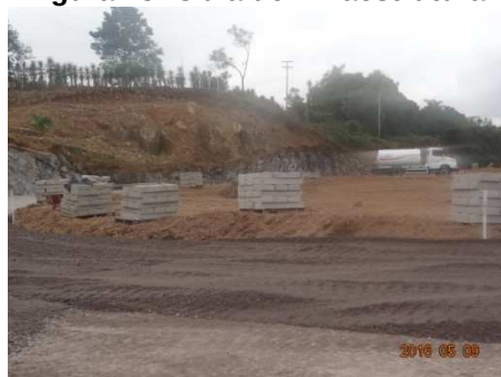
Figura 13: Obra de infraestrutura.
