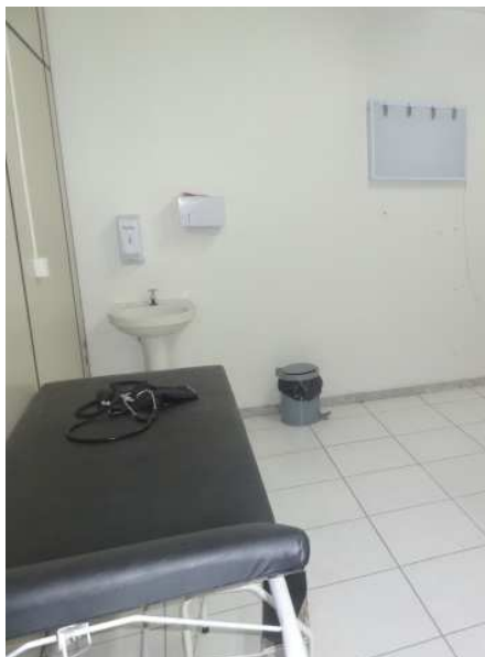
Figura 130: Recipientes para armazenamento temporário dos resíduos biológicos no posto de saúde de São Luiz de Castro.
