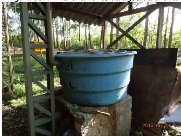
Figura 85: Armazenamento da água da chuva.
