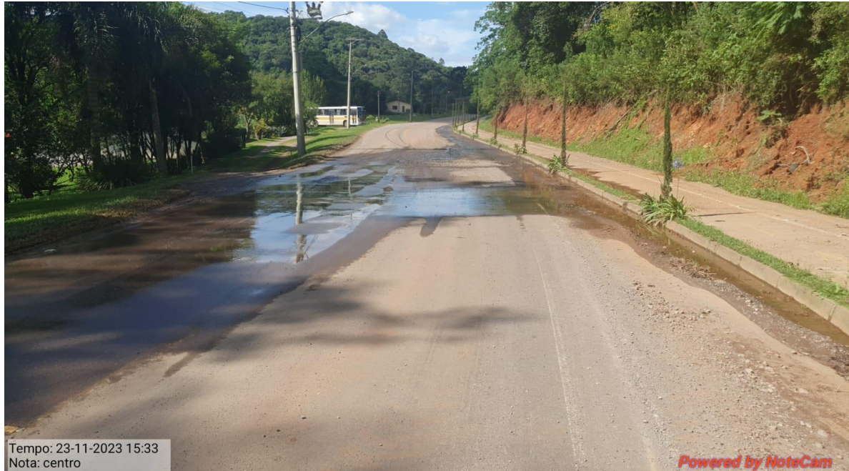
Foto 06. Trecho próximo à sede do município
